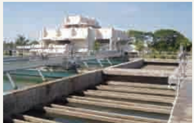
フィリピン・バタンガス市水道事業：浄水場沈殿地
