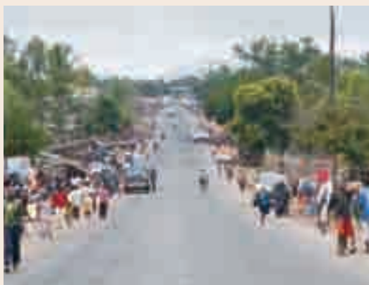
道路が舗装され、交通アクセスが改善(モザンビーク)
