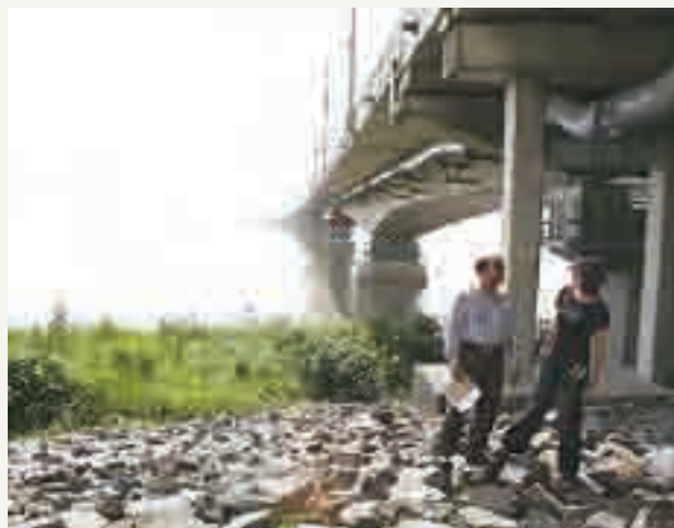
道路のほか、送電線やガスパイプラインも併設しているジャムナ多目的橋梁
