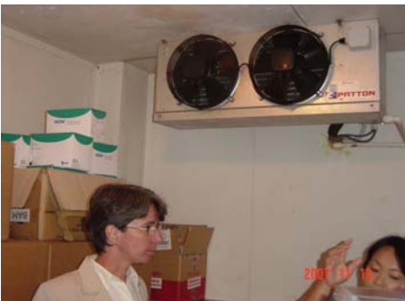
＜WHO/PacELF＞検査キット（ICT）用コールドルーム内の冷却装置。大型ファンで空調が制御されている。
