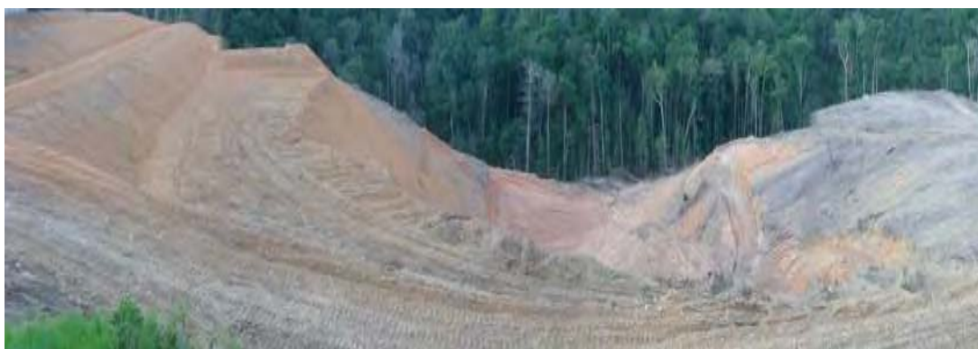
図 4 - 1 7 CETRAM社が建設中の産業廃棄物処分場
