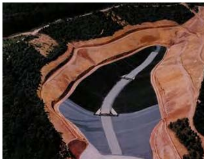
図 5 - 5 サンパウロ郊外に建設中の管理型廃棄物処分場
