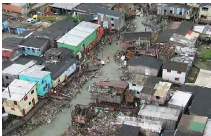
マナウス市のイガラペ（周辺の不法住居及び劣悪な環境を示している）
