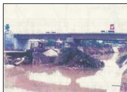
写真-2 2000年10月台風 Reming による洪水後、橋梁の下に堆積した土石 (Source: IDI-Japan)
