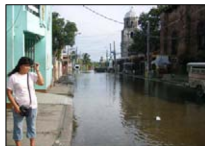
写真-4 高潮位による浸水(2007年8月本調査団による)
