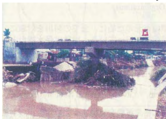
図 R.5.6 閉塞状況 (Ilang-Ilang 橋)
