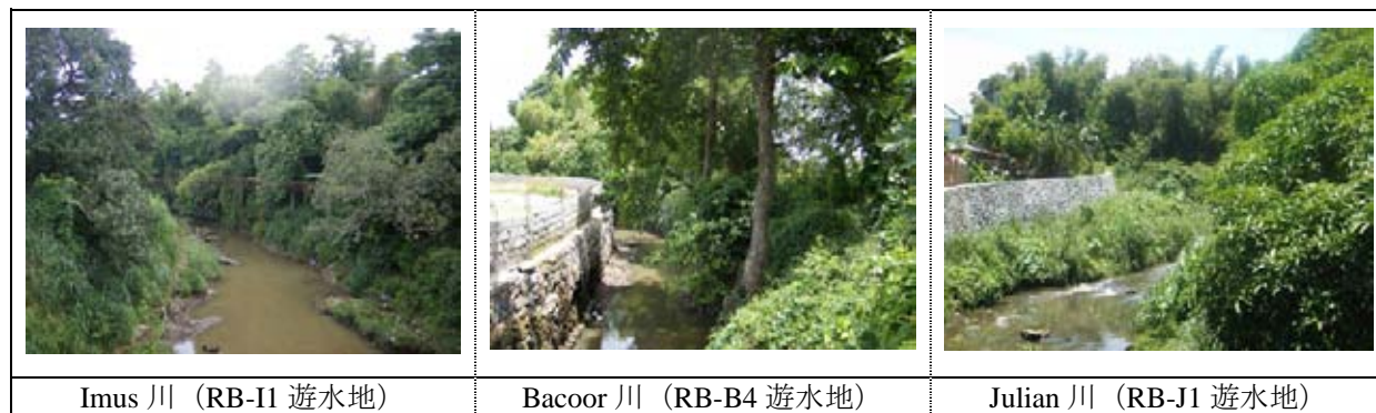
図 3 遊水地建設予定地付近の各河川の現況写真
