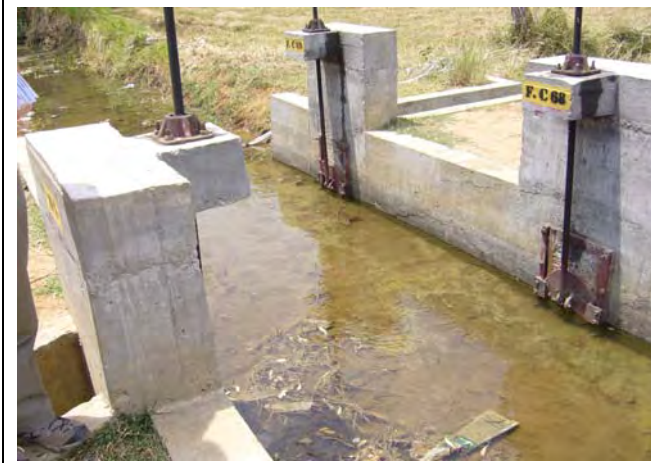
写真3 修復された灌漑施設
