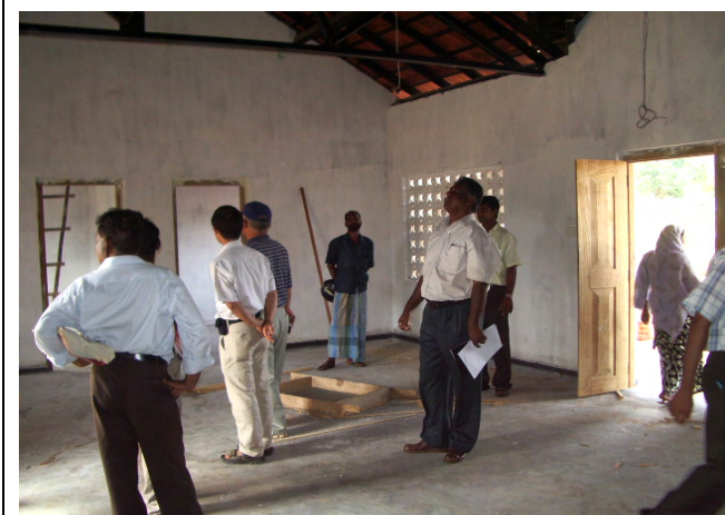
写真5 建設されたコミュニティーホールの 現地調査
