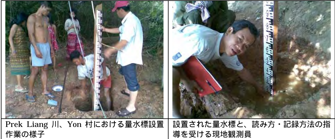
図 9.4.1 量水標の設置作業と観測指導
