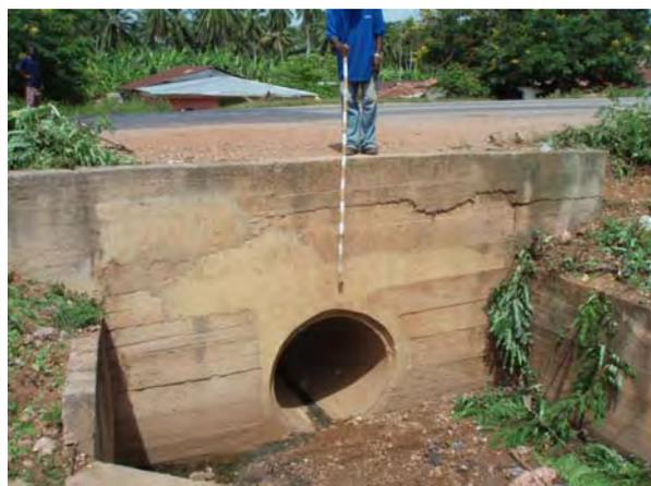
写真-11：道路横断暗渠(コンクリート管)
