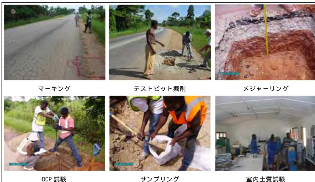
図 2-22 テストピットの作業状況
