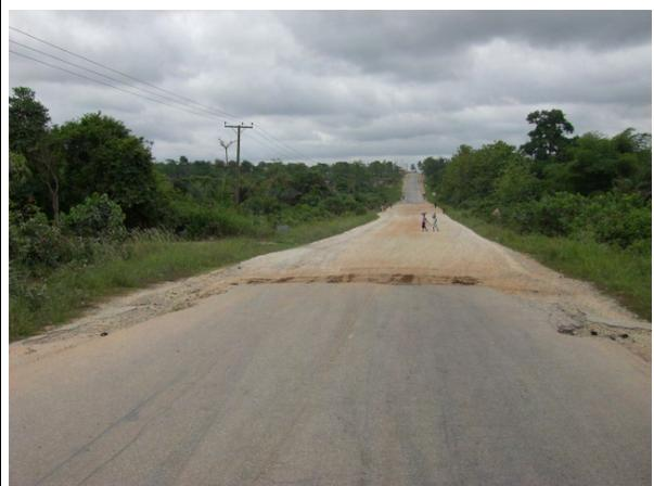
写真-6：舗装表層の散逸
