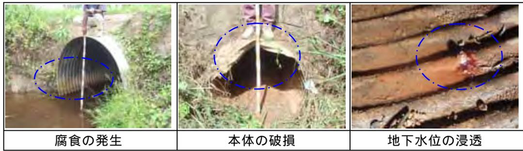
図 2-14 コルゲートパイプの変状状況
