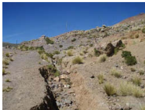
13 Arroyo de 0.8 m de ancho y 1.0 m de profundidad
