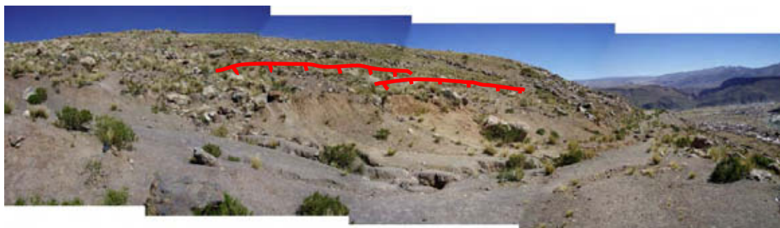
14 Distribución de arroyos profundos y escarpas de derrumbe (línea roja) en el talud del lado este de la Planta de Tratamiento de Agua Río San Juan
