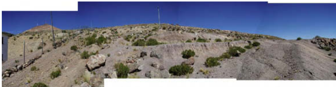
11 Aspecto del talud candidato para la ampliación de la Planta de Tratamiento de Agua Río San Juan
