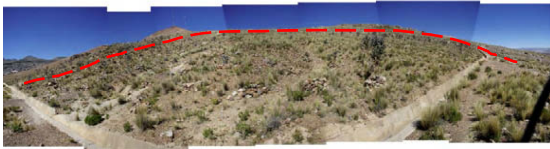
⑥ Rio Sun Juan 浄水場の上方斜面に分布するガリーと崩壊地形（赤破線）の状況.
