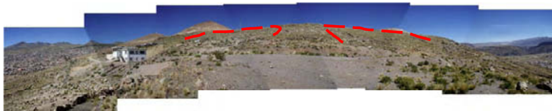
Rio Sun Juan 浄水場東側斜面の斜面全景
