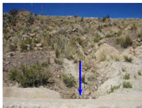
④ 斜面から既設排水路に向かってできたガリー（表流水の浸食によりできた凹路）.
