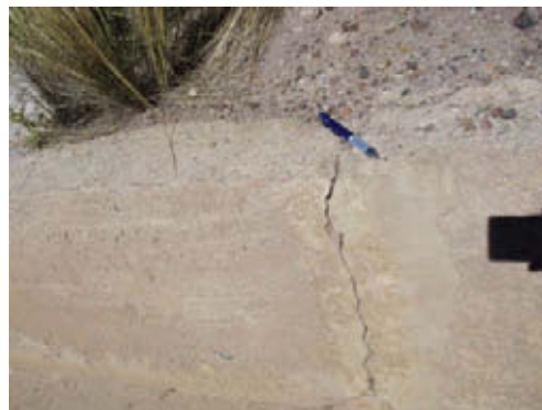
⑦ 浄水場の東側上方斜面にある既設排水路 ⑧ 既設排水路のヘアークラックの状況. には、ヘアークラックが分布する.
