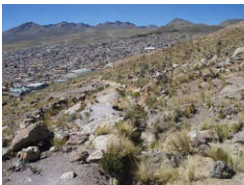
⑨ 既設排水路（コンクリート製）に続いて 素掘りの排水路が作られている.
