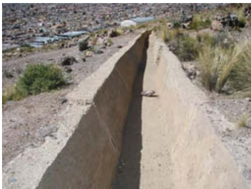
⑦ 浄水場の東側上方斜面にある既設排水路 ⑧ 既設排水路のヘアークラックの状況. には、ヘアークラックが分布する.
