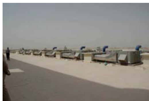
شكل 7-61 : سطح مبنى وزارة المياه والكهرباء
