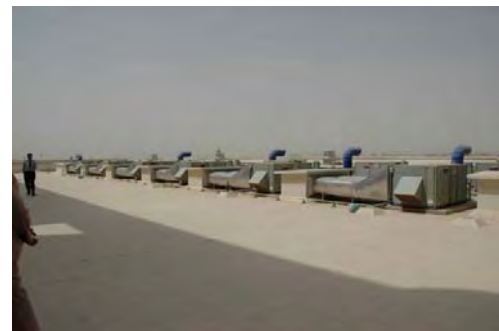
図 7-61 MOWE 事務所建物屋上
