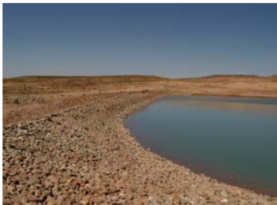
既存のため池（護岸整備されていない）
