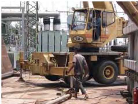
BPDB 発電所例
