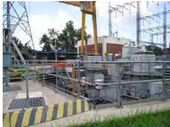
安全策の設置（転落防止）
