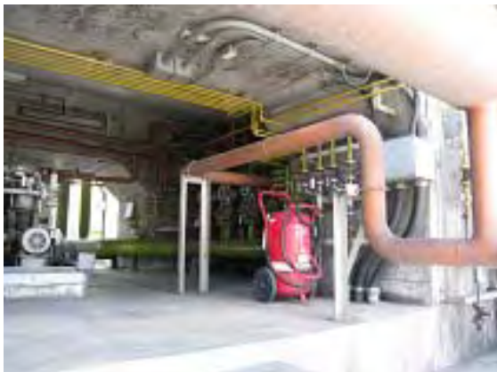
消火設備の設置
