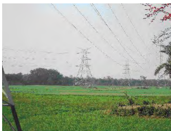
Figure I-4-4-4 ベラマラ変電所近傍の状況
