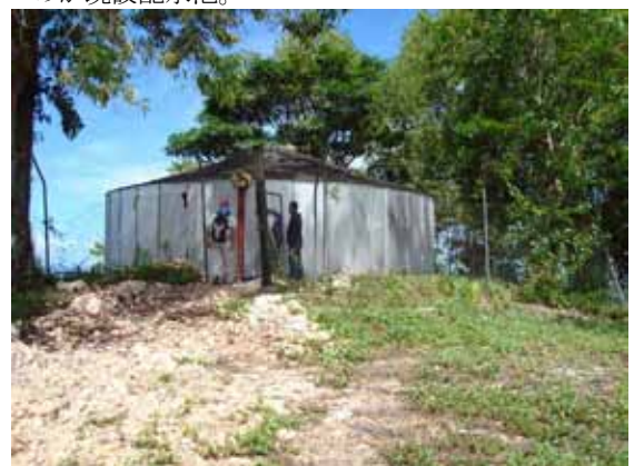
アウキ市の既設高所配水池。新しく開発される井戸水は、このタンクに送られる。
