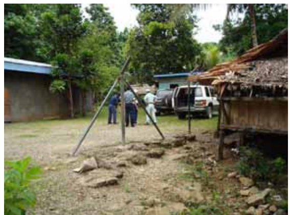
コングライ高濁度対応型調整池予定地。写真左に見られる建物は、移設予定の既設コングライポンプ場。
