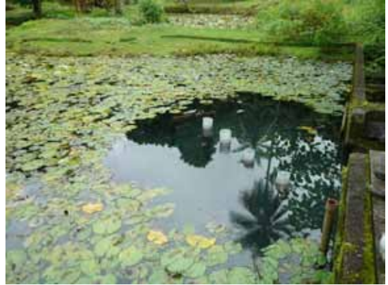
ロベ湧水の取水部。発生したオタマジヤクシがそのまま給水される問題が起きている
