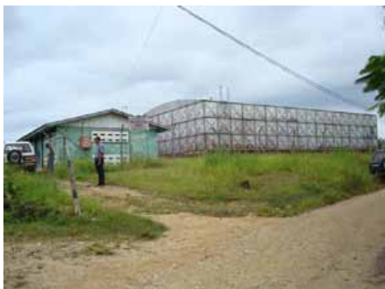
タサへ配水池。左の既設塩素滅菌施設が撤去され、右の既設配水池の隣に、新しい配水池が建設される。
