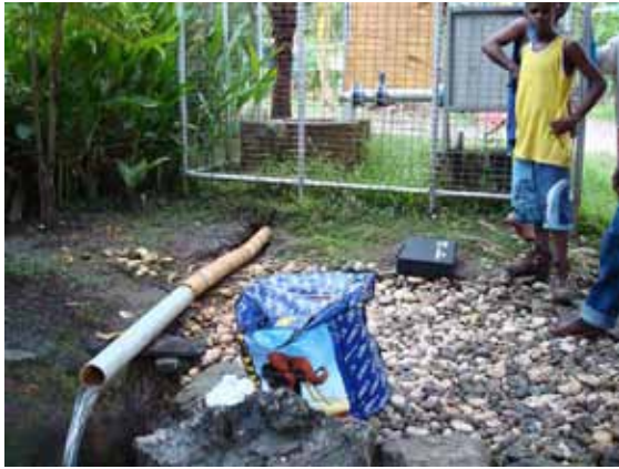
既設ホワイトリバー井戸 (1996年に日本の援助で建設)。この水は常に清澄で市民に欠かせない水となっている。
