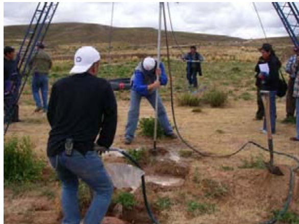
掘削部品挿入中
