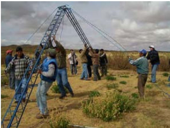
手掘井戸掘削機（組み立て中）
