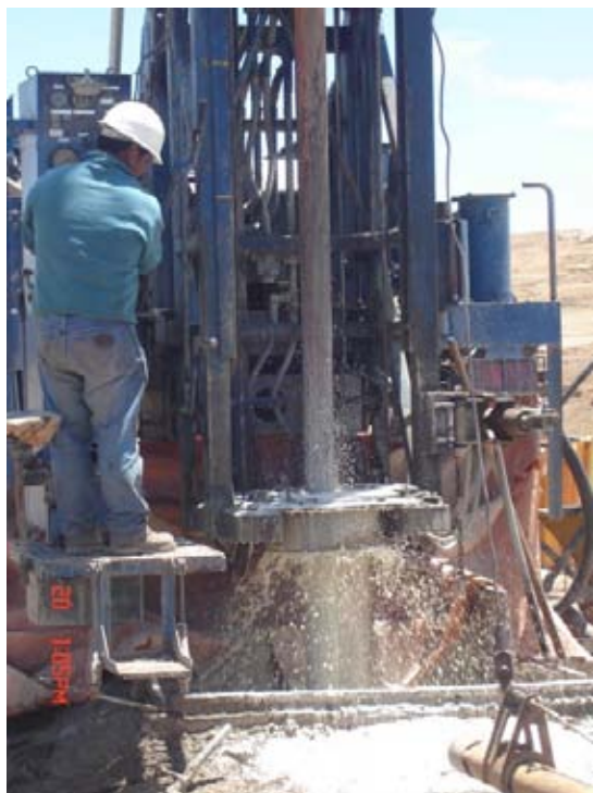
井戸掘削の様子
