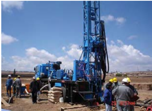
無償資金協力で供与した井戸掘削機
