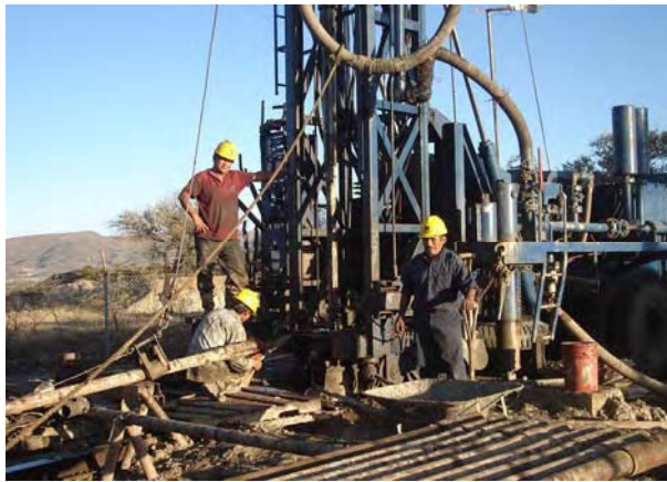
井戸掘削の様子
