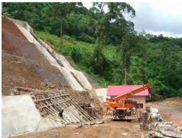
水圧管路(内径600~800mm、延長63m)及び発電所
