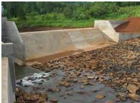
取水堰（堤高5.2m、堤長60.0m）
