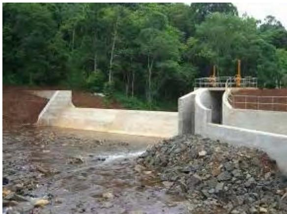
取水堰（堤高4.3m、堤長41.0m）
