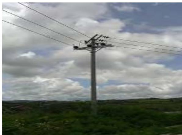
22kV 送電線用柱（PC補強コンクリート柱）
