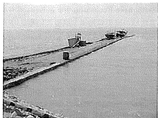
写真-10 タッタ県ケティバンダ突堤
