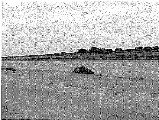
写真-4 シンド県 LBOD 水路河岸護岸補強
