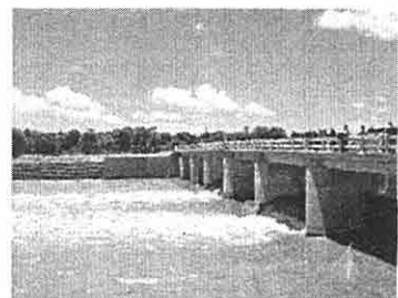
ダムナック・アンピル頭首工
