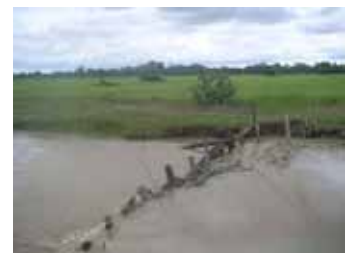
幹線水路には恒久付帯施設がみられない。分水は木製の水位調整設備により行われている。(2008年6月12日撮影)
