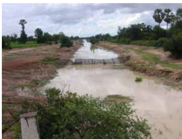
農家による幹線用水路内の養魚池運営 (ワット・チェレ改修サブ・プロジェクト) (2008年9月13日)
