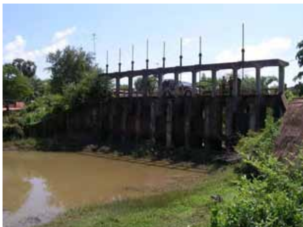
機能を失った既存頭首工 (リア・ムコン改修サブ・プロジェクト) (2008年5月25日)
