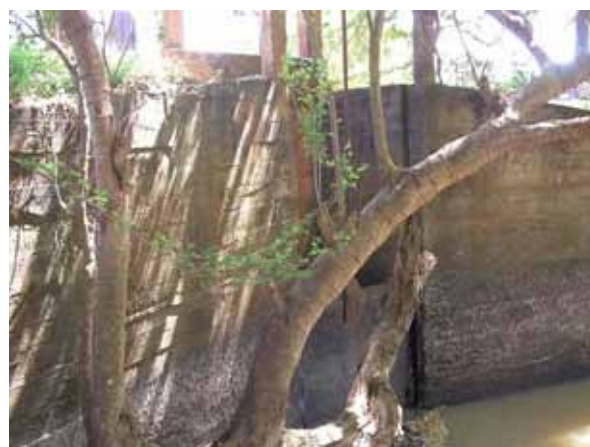
既存取水口の状況 (ポー水路改修サブ・プロジェクト) (2008年5月25日)
