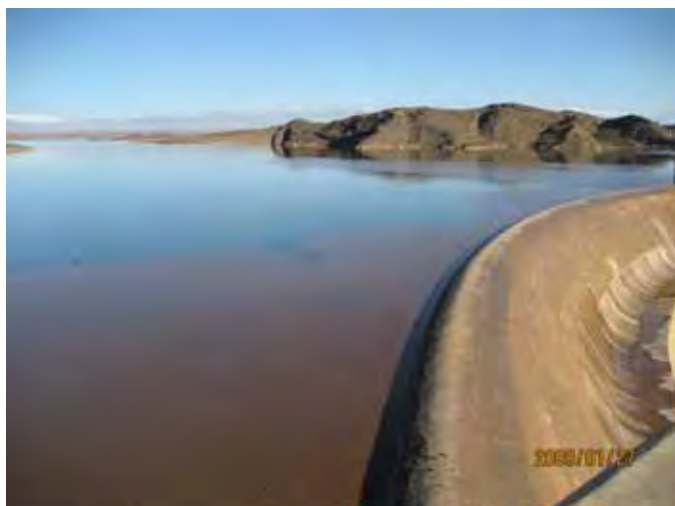
Mansour Eddahbi ダム（ワルザザット郊外）
