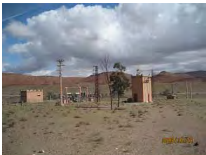
Dades 近郊の変電所
