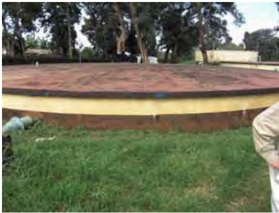
カンガル浄水場。既設配水池
