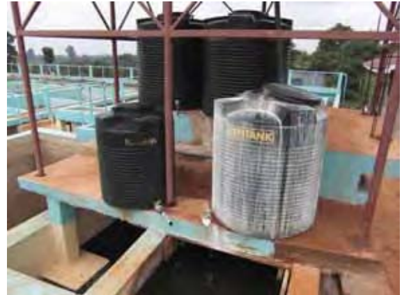
EWASCO が建設中のムカング浄水場。 薬品タンク
