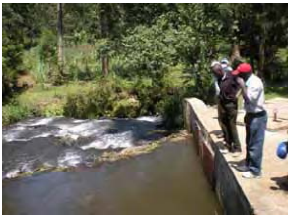
取水候補地No. 4. 既設EWASCO 取水地点 標高 1,678m。
