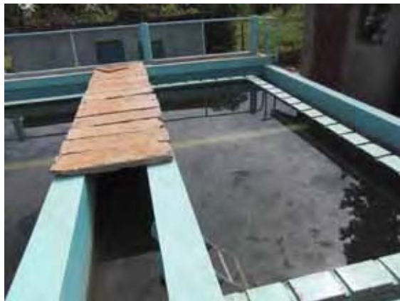
EWASCO が建設中のムカング浄水場。 高速凝集沈殿池
