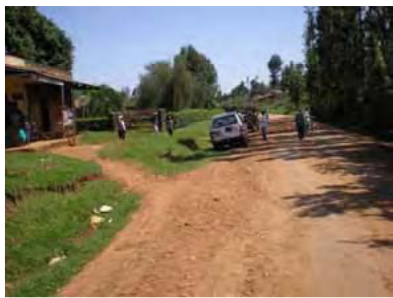
導水管路(公道)。公道最高高は標高 1,657m。
