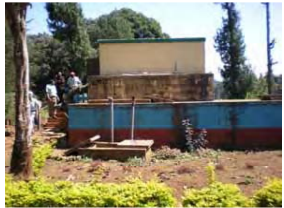
ガンドリ・ギンダー組合塩素注入井。 標高 1,880m。塩素処理のみで近隣へ給水。
