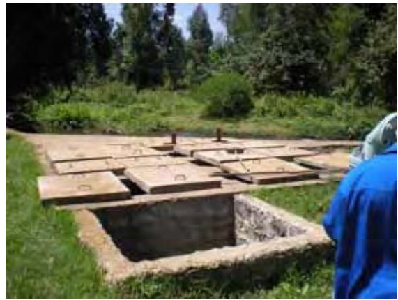
取水候補地No. 4. 取水チャンバーには増設分のスペースが確保されている。
