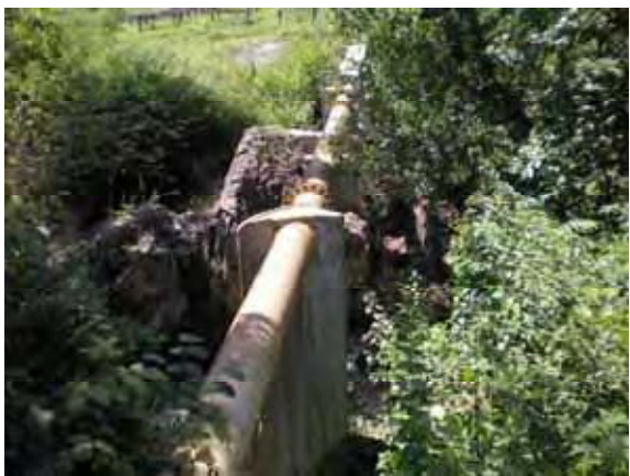
導水管。ルピンガジ川水管橋。標高 1,621m。 ここから民有地に敷設されている。
