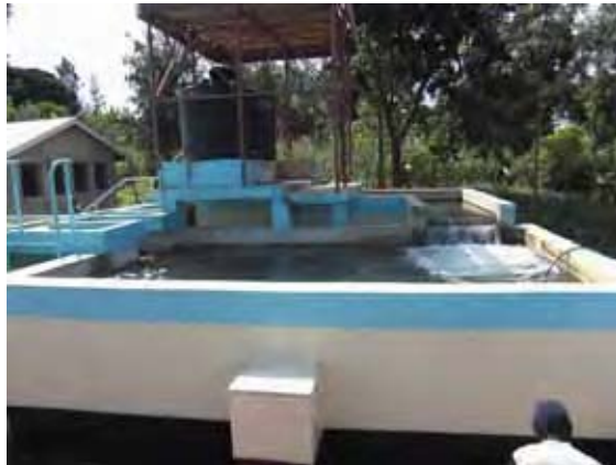
EWASCO が建設中のムカング浄水場。 着水井
