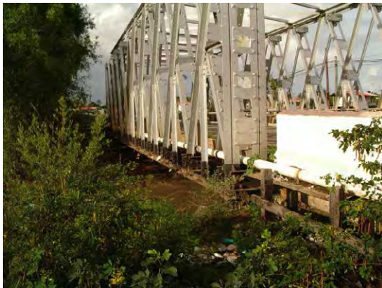
【事業化調査対象区域】既設配水管水路横断、既設橋添架状況。
