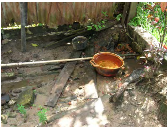
水圧が低い各戸給水状況。屋内の給水栓では水圧が不足するため、庭先に給水栓をつけそこから水を汲んでいる。
