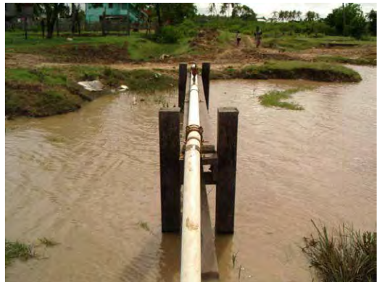
木杭式の水管橋で水路横断している。ガイアナ水道公社の標準水管橋で硬質木杭は腐食に対し非常に強く、広く採用されている。
