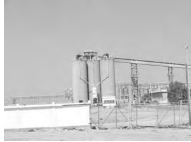
輸入小麦用のコンクリートサイロ
