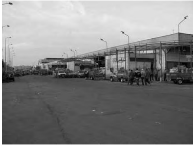
1994年建設だが雨が降らないため、建物の傷みは少ない
