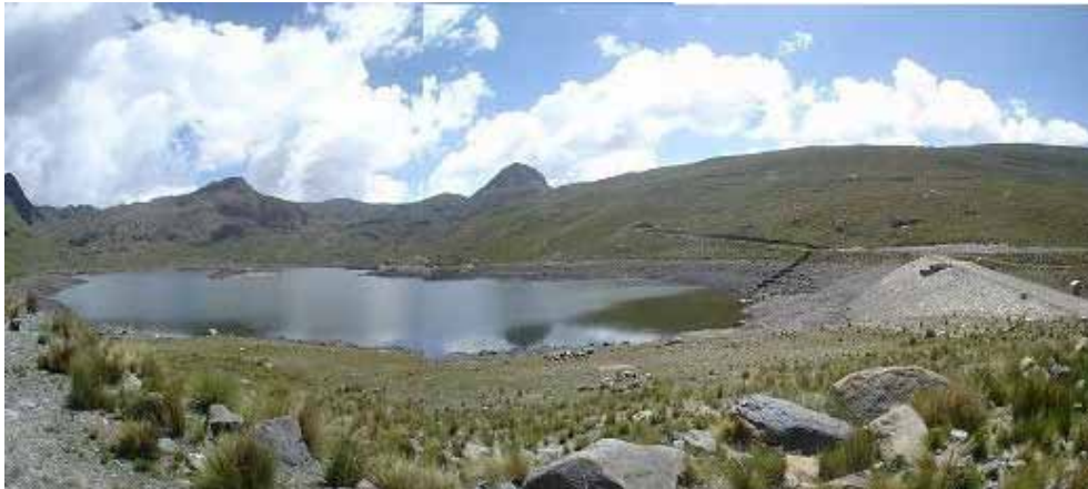
La Represa Wara Wara que es la fuente de la Planta de Tratamiento Aranjuez. El volumen almacenado este año ha sido reducido por el estiaje.
