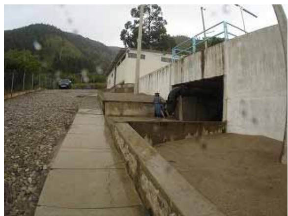
El terreno donde se propone construir el tanque de filtración de la Planta de Tratamiento Aranjuez.
