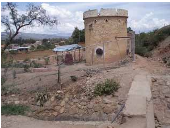
El sistema de abastecimiento de agua del comité, que consiste en el pozo y la bomba.
