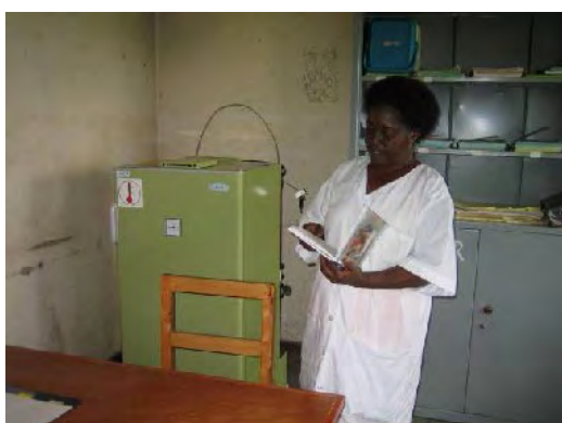
各保健センターにはワクチン保管用の冷蔵庫がある。動力源は、電気もしくは灯油である。
