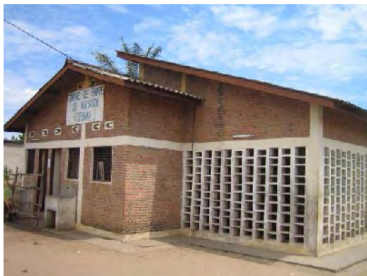
ムタクラ保健センターの外観。保健センターの多くは同じレイアウトの建物になっている。
