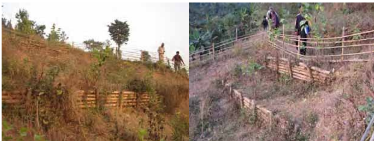
図 6.6.1 簡易な斜面安定対策工の状況 (2008 年 11 月)
