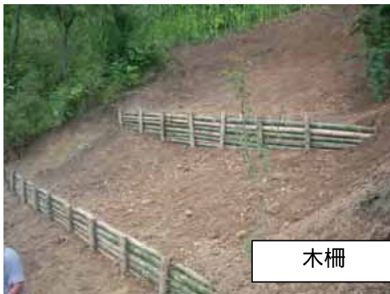
図 6.5.10 簡易構造物対策の施工状況 (2008年6月)
