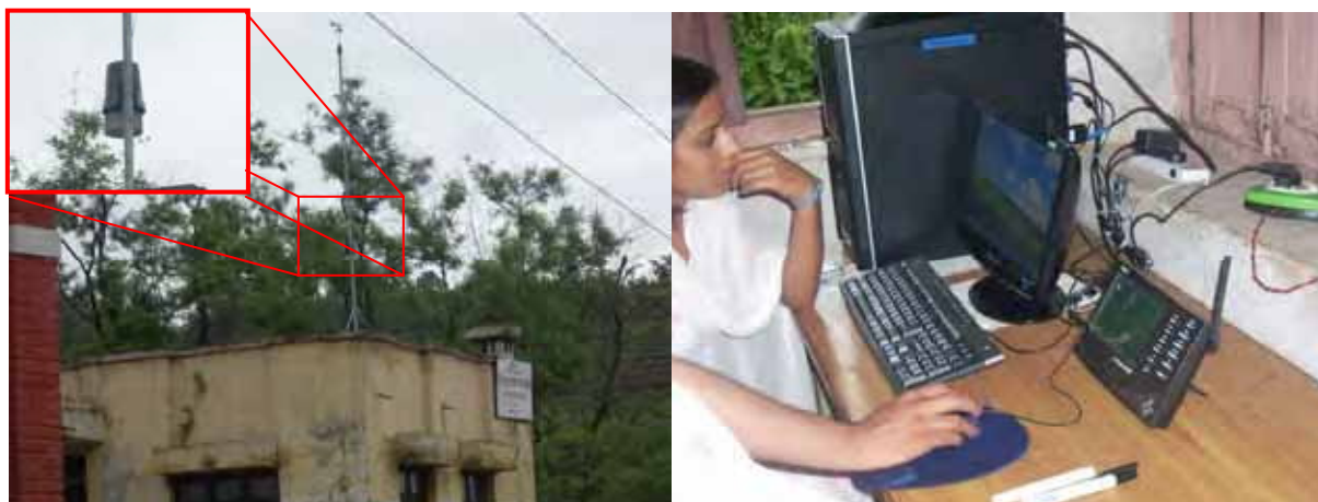
図 6.5.7 雨量計（左）とコンピューターシステム（右）の設置状況
