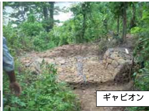
図 6.5.10 簡易構造物対策の施工状況 (2008年6月)
