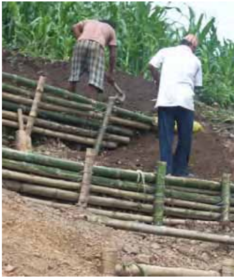
簡易な対策構造物の設置状況 (木柵・ギャビオン)
