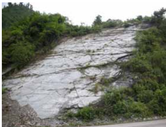
図 3.1.11 基盤岩の層理面すべりによって形成された典型的な流れ盤斜面（CH 25+500, リグディコーラ（Rigdi Khola）付近）
