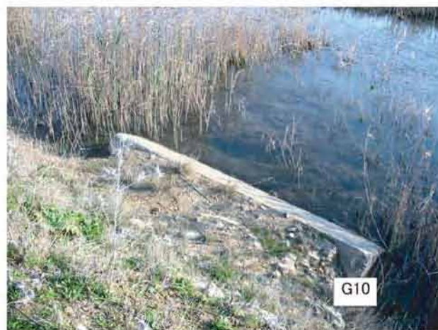
Figure 8.3.3 Conditions Actuelles des Ecluses le long du Canal El Mabtouh
