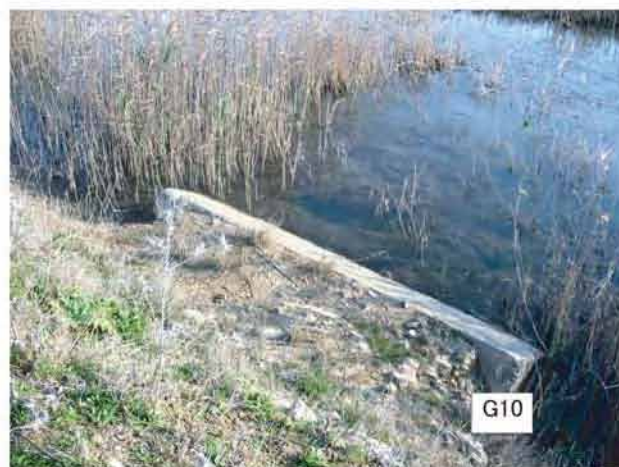
図8.3.3 エルマプトゥ水路の現況樋門
