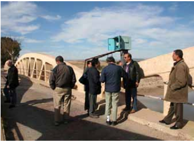
カウンターパートとの現地踏査 (2006年12月)
