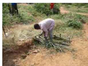
粗朶柵工による土壌流出抑止工
