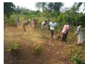
本工事開始前の草刈り作業
