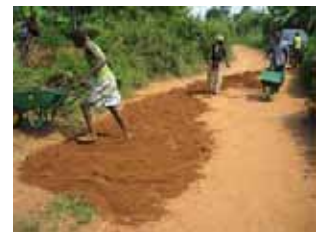
FP 掘削発生土を道路修繕に利用
