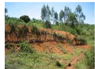
盛土法尻部に建設した土砂流出防止用フェンス
