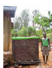
木枠製雨水貯留槽 設置状況
