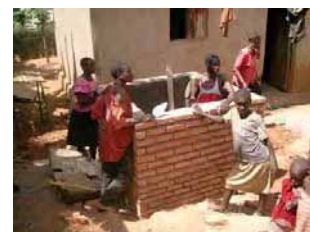
レンガを利用した箱型水槽 (調査団提案型)
