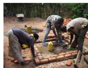
水槽レンガ壁の積み上げを手伝う女性モデル農家
