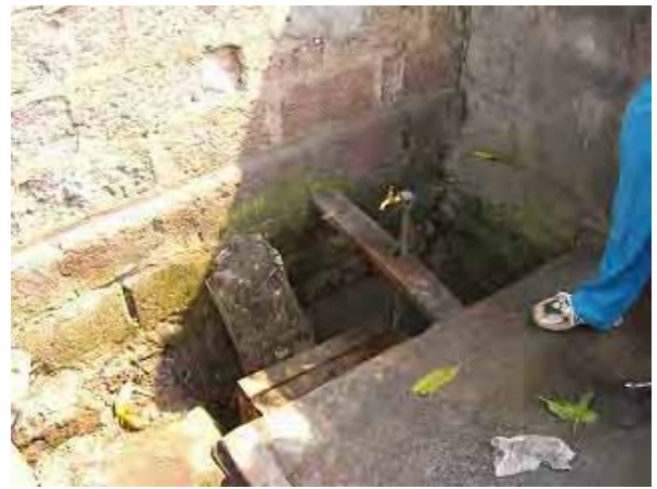
水圧が低いために水道管を掘り下げ、 蛇口を低い位置に取り付けている (それでも水が出るのは夜1時~3時)
