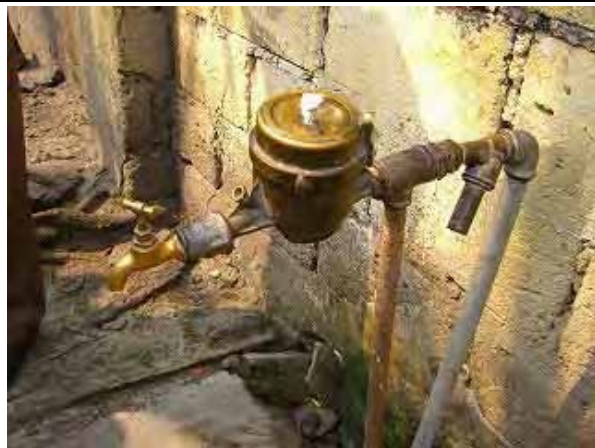
故障している水道メーター。メーター上流部に 分岐を取り付けており、盗水状態となっている
