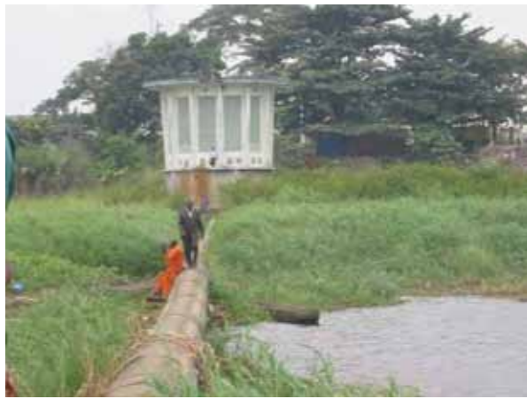
下流側取水塔 No.1 (稼働していない)
