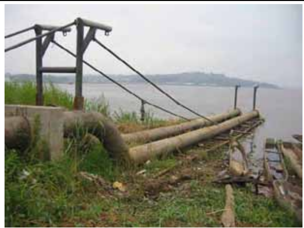
コンゴ河に突き出した取水管
