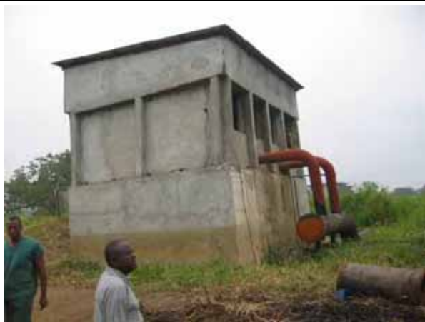
上流部取水塔 No.3
