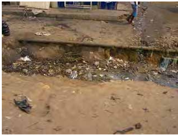
洗掘された道路に露出した水道管 (鋼管の腐食が目立つ)
