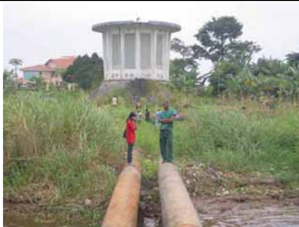
中間の取水塔 No.2 上流側サイフォン管 (左) のみ使用
