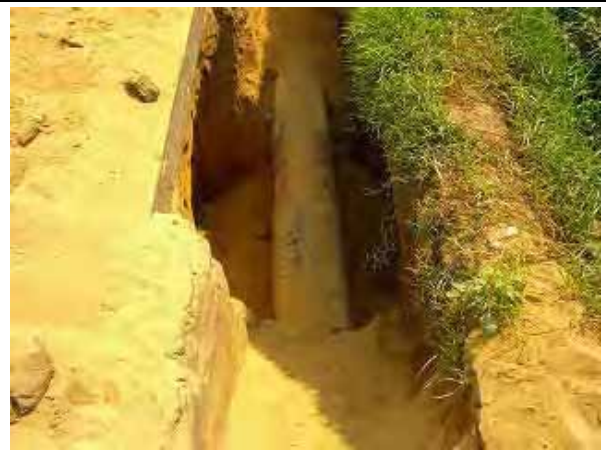
EUによる管路敷設工事現場 鋼管溶接部分
