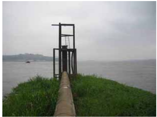
コンゴ河に突き出した取水管・サイフォン管 (稼働していない)
