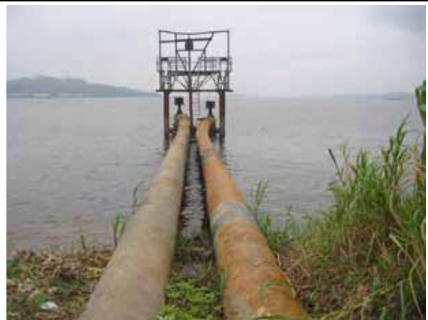
コンゴ河からの取水管・サイフォン管 (右のみ稼働)
