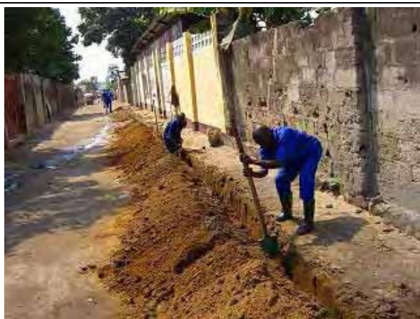
EUによる管路敷設工事現場 小口径管で REGIDESO の職員により 工事が実施されている
