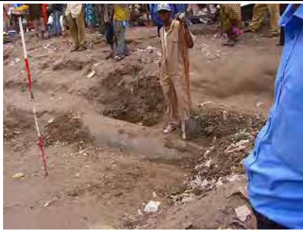
道路工事で掘り出された水道幹線 (鋼管)
