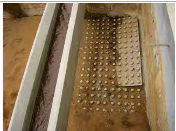
めくれ上がってしまった砂ろ過池 下部集水装置
