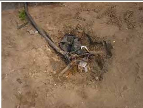
コミュン内でよく見られる地中電線 掘削時に非常に危険・感電死亡者も多数
