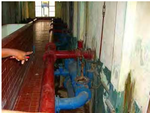
砂ろ過池管廊・老朽化した電動バルブ類 (電動では操作できない)
