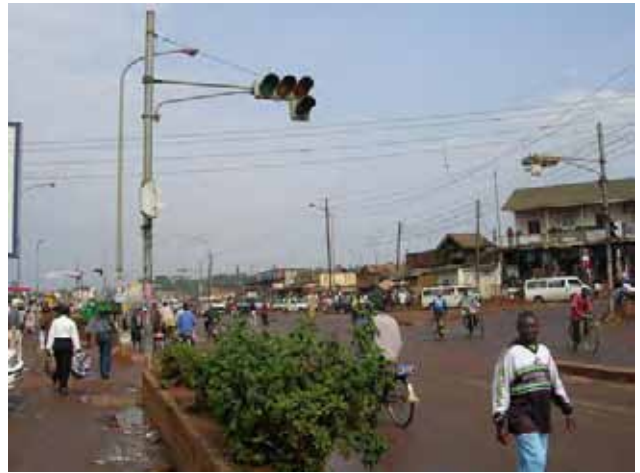
ナテテジャンクション 日本の無償第一期にて交差点改良、信号機設置。踏査時には電気不通であった。
