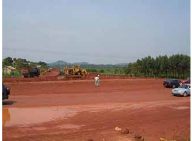
北部バイパス（EU 資金）の建設現場
