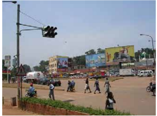
Wandegeya ジャンクション 日本の無償第一期にて交差点改良、信号機設置。踏査時には電気不通で、警官が交通整理にあっていた。
