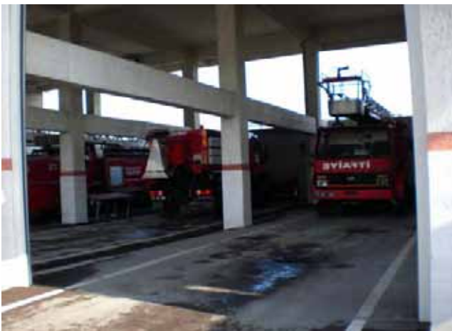
P-19 消防署施設(1)
