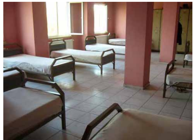
P-20 消防署施設(2)
