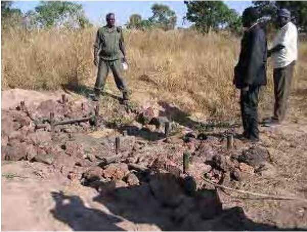
土壌浸食対策として日本人専門家の指導によって村人が作製した杵堰。6月～10月の雨季の集中豪雨時には、降雨で土壌が流され、馬車等が通りにくくなり道路が寸断されるところもある。(Ndiakhene 村)
