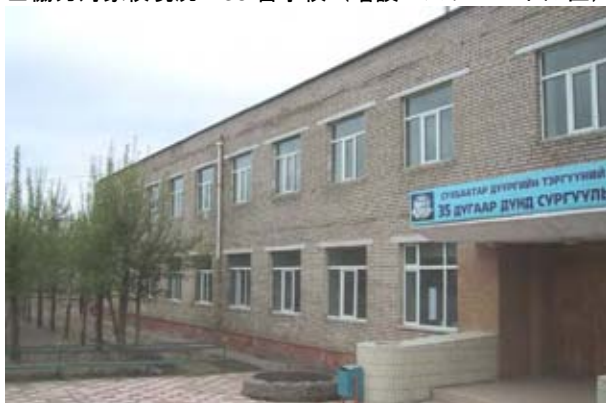
既存南校舎正面外観。
