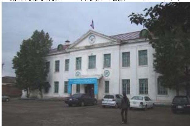
既存校舎正面外観。市西部で最初に建設された校舎である。
