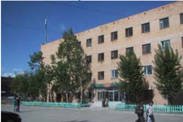
既存校舎正面外観。軍関係施設を転用したものの。
