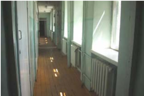
幼稚園として建設されたため廊下は幅 1.2m と狭い。
