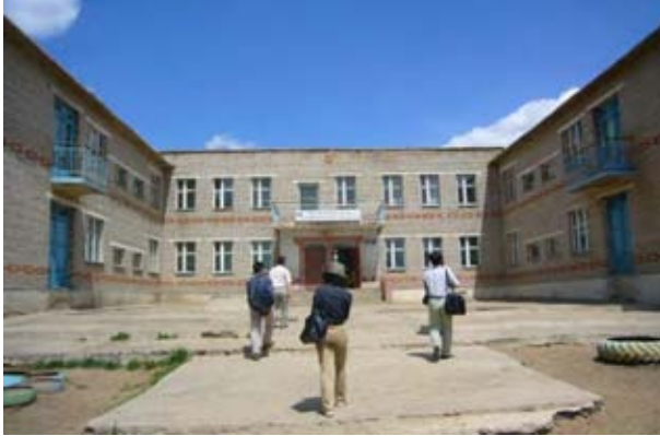
既存小学校校舎正面。幼稚園として建設された建物を転用。
