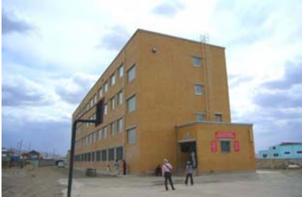
ハノール区 114 番学校 (1/4 期-18 教室棟新設) 外観。
