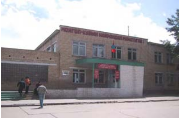
既存校舎入口部分。1970～80 年代に多く建設された標準校舎。
