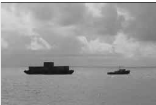
写真-10 バージの曳航状況 (実入りコン)
