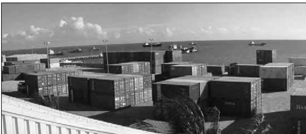
写真-3 コンテナヤードの全景
