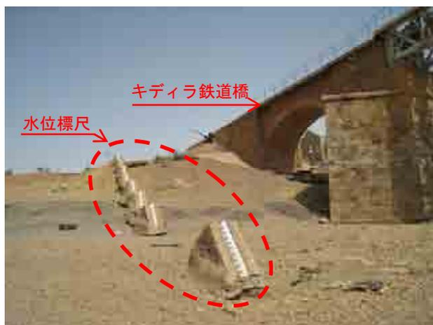
図 3.2.2-2 水位標尺（写真右側に鉄道橋）
