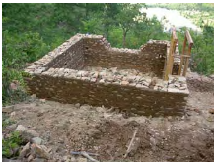
観測小屋作業途中 1
