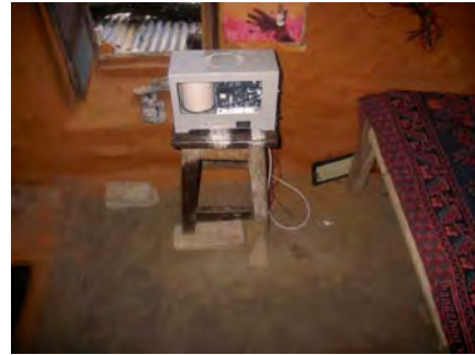
雨量計設置完了 4
