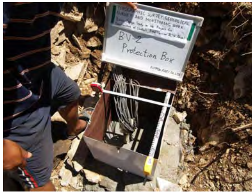
写真 8-7-5 BV-2. 保護箱設置状況
