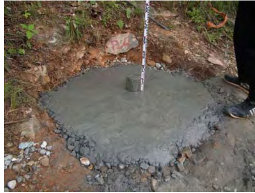
写真 8-7-11 基礎掘削状況と移動杭設置完了
