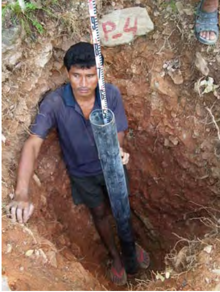
写真 8-7-11 基礎掘削状況と移動杭設置完了
