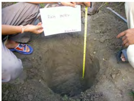
雨量計設置状況 1
