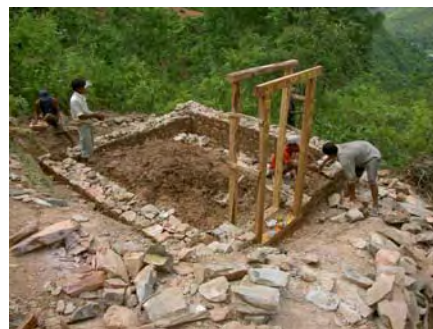
観測小屋作業途中 2
