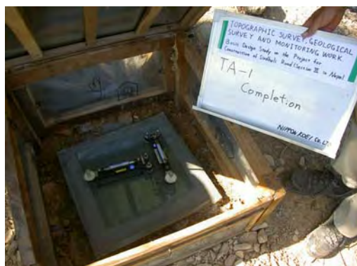
写真 8-7-10 地盤傾斜計設置完了
