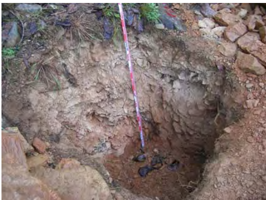
写真 8-7-8 基礎掘削状況
