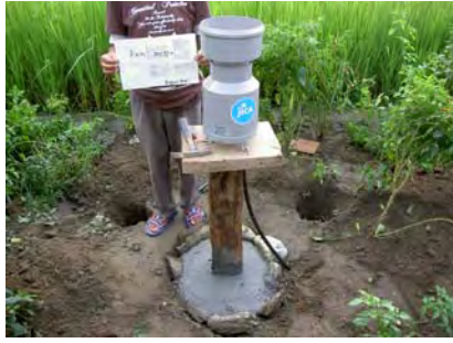
雨量計設置完了 1
