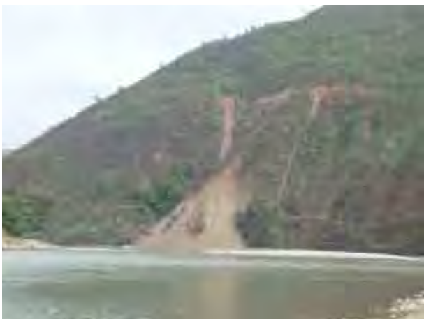
ムルコット大崩壊地と既存道路 スンコシ川河岸付近に大崩壊が発生しており、 既存道路はその上部を通っている。
