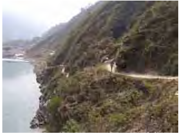
STA.0+800 付近の既存歩道 スンコシ川に沿った岩盤の急峻地形で、 山ひだも複雑になっている。
