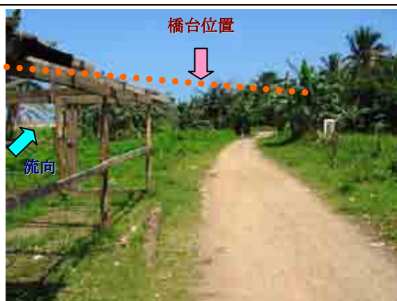
写真 C-5： 右岸（ジェネラル・ナカール）側の橋台位置。
