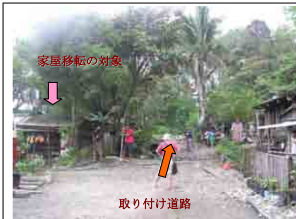
写真 C-1： 左岸（ディンガラ）側の取付道路の始点付近、移転対象の家屋は2世帯。
