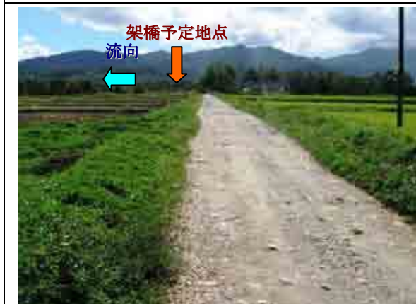
写真 B-3: 左岸（マラシン・バランガイ）側の接続道路、周辺是水田・畑で影響する家屋はない。
