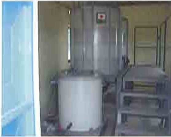
第1期工事で各配水池に設置された消毒設備。(粉末塩素剤溶解タンク、注入機一式)
