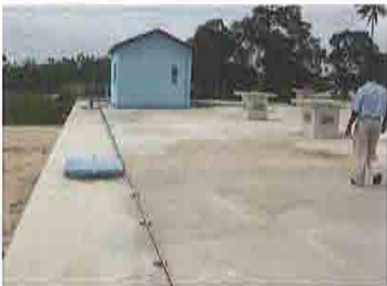
第1期工事で建設された、ウェレゾ配水池(No.1:4,000m 3 ×1池、RC造、矩形)。
