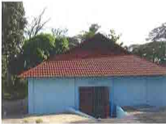
第1期工事で改修された、サテニ・ステーション敷地内の送水ポンプ棟建屋。
