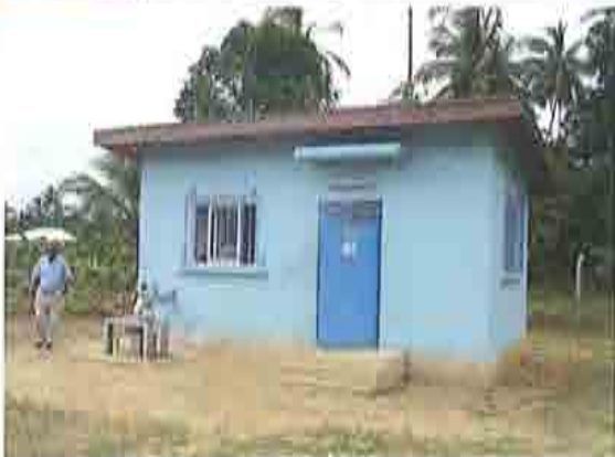
第1期工事で建設された井戸施設。(写真はN-13)
