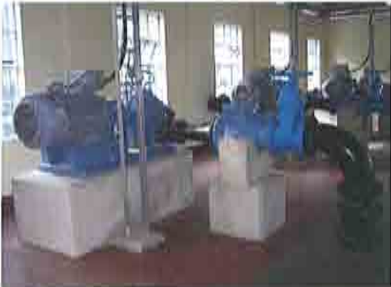
第1期工事で設置された、サテニ・ステーションの送水ポンプ。 (横型両吸込渦巻ポンプ： 400m 3 /hr×40m×2台、200m 3 /hr ×40m×2台)
