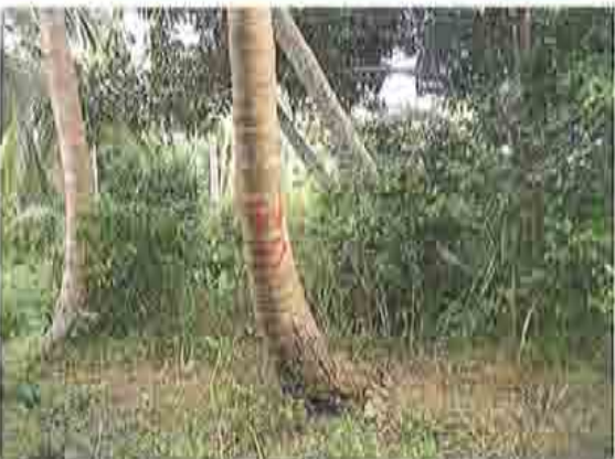
第2期工事、井戸建設予定地。工事に支障となるものは無い。(写真はN-12)
