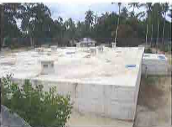
第1期工事で建設された、ウェレゾ配水池(No.2:4,000m 3 ×1池、RC造、矩形)。
