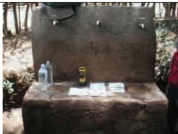
写真-8 既存施設（公共水栓） 州内で公共水栓の形は統一されていないが、水タンク置きは共通して見られる。
