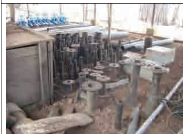
写真-11 資機材保管状況 管材等がパーツの種類別に整理されており、資機材の保管状況は良好である。（ホロ・グドゥル県水資源オフィス）
