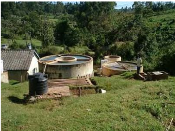
写真-2 既存浄水場:全3系列の内、2系列が稼働中。
