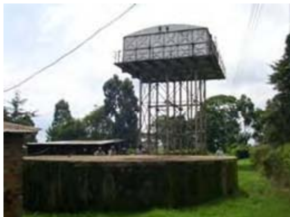
写真-7 既存カプサベットハイスクール配水池、高架タンク:本プロジェクト完成後も活用する。
