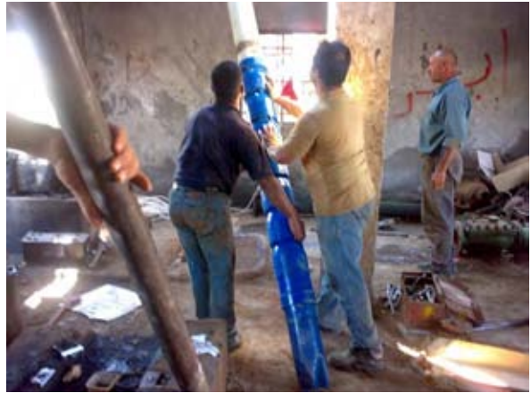
Installation of Pump Equipment (19-19/005A, Ein Al Byhda)
