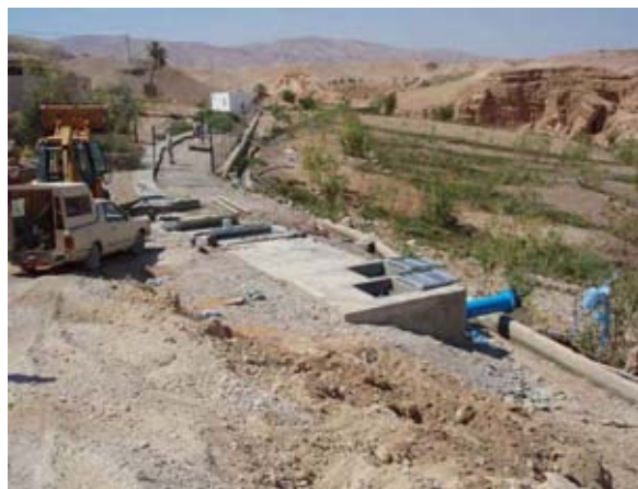
ヌエイマ湧水上流部改修後
