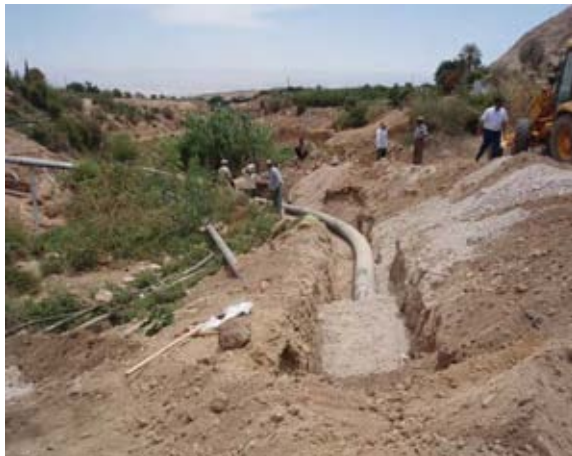
ヌエイマ湧水パイプ敷設
