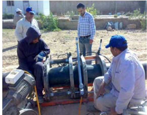
パイプ溶接作業
