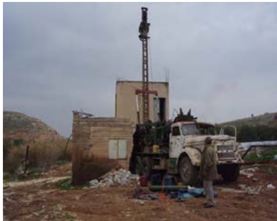
井戸追加掘削
