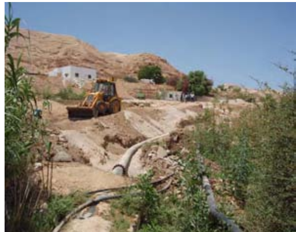
ヌエイマ湧水パイプ敷設
